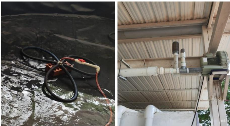
Nota: a la derecha se aprecia el *blower* encargado de dar el respaldo de oxígeno. En la izquierda se aprecia las mangueras difusoras de oxígeno encargadas de distribuir el aire proporcionado por el *blower*.
