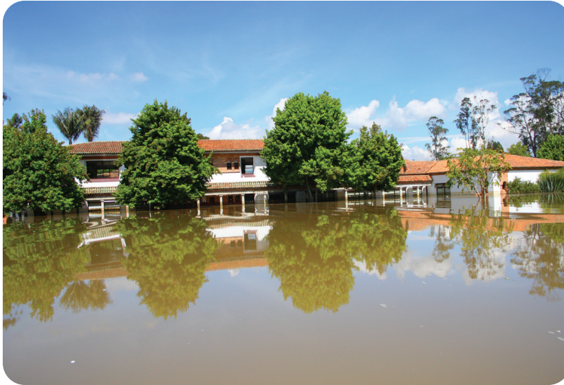
Anfiteatro edificio F y edificio H anegados en el campus del Puente del Común, Chía, 2011.
